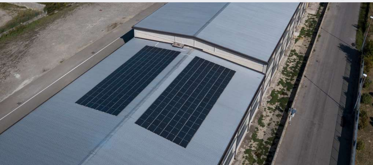
Installazione dei pannelli fotovoltaici operativi da ottobre 2022
